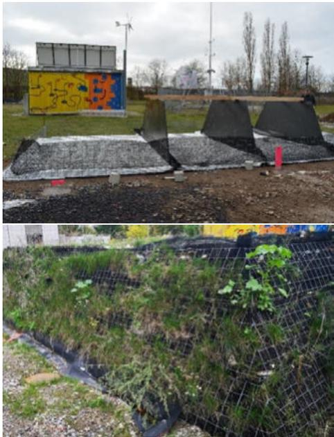
Abbildung 3: oben: Ansicht der Aufstandsfläche vor Beginn der Verlegearbeiten der KBE-Konstruktion; unten: Nordwestansicht der begrünten Konstruktion im Oktober 2020 (Bildautorin: Schneider)
