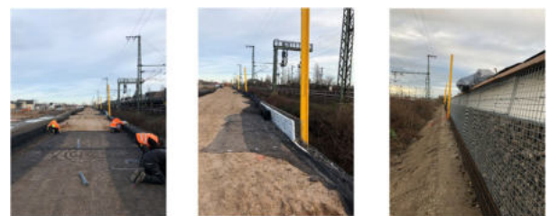
Abbildung 2-11: Bauphase KBE-Konstruktion
