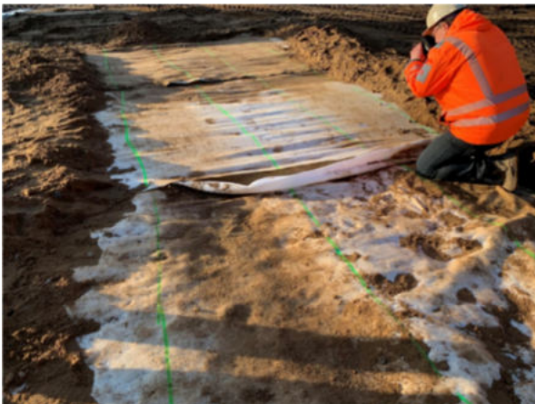
Abbildung 3-1: Gespannte und entspannte Proben nach dem Abtragen des Schüttmaterials
