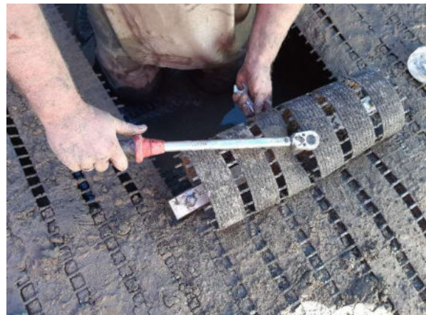
Abbildung 13: Anziehen der Verschraubung der Klemmvorrichtung mit definiertem Drehmoment.
