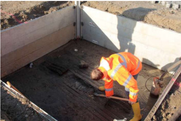
Abbildung 11: Händischer Aushub bis zur zweiten Geogitterlage.
