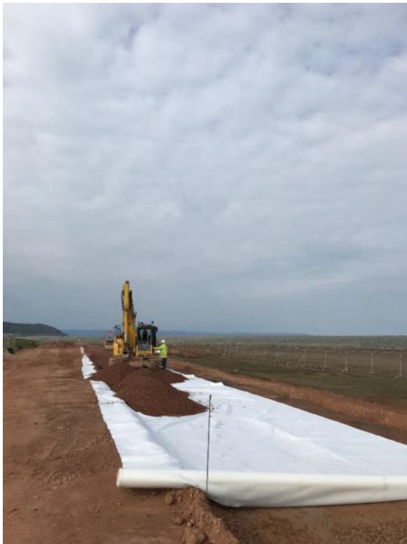
Abbildung 4-1: Einbau eines biologisch abbaubaren Trenn- und Filtervliesstoffs in einem Naturreservat in Devon, UK.
