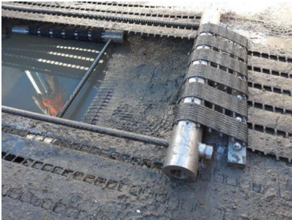
Abbildung 14: Detailaufnahme der fertig eingebauten Spannvorrichtung.
