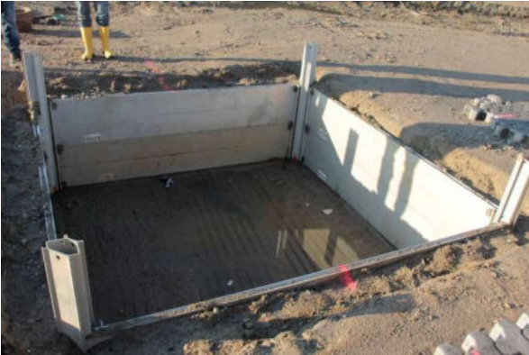
Abbildung 10: Baugrube mit freigelegter oberer Geogitterlage.
