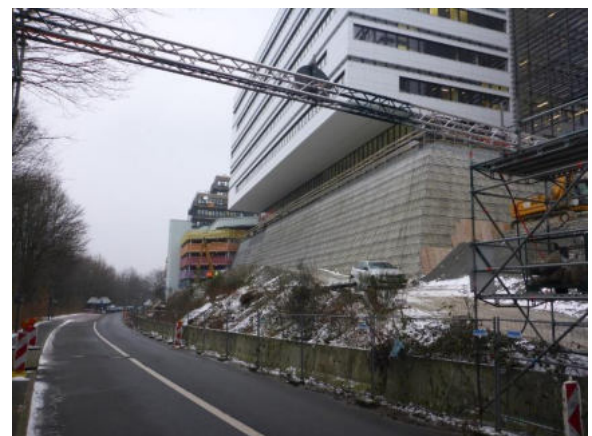
Abbildung 3: Ersatzneubau in Hanglage mit vorge-setzter EVK
