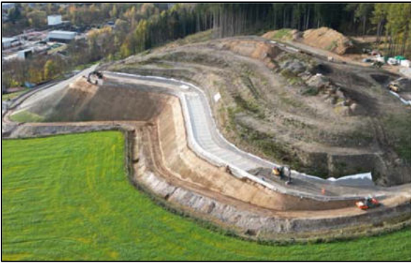
Abbildung 2-7: Bauzustand der KBE (ca. Ende 2022)
