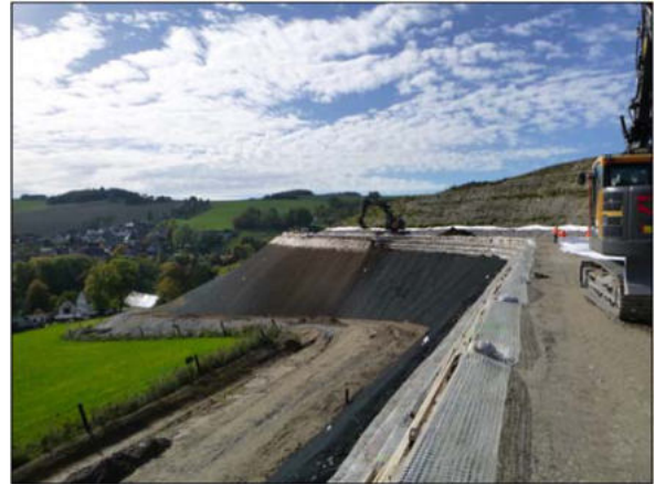
Abbildung 2-5: Aufbringung des Oberbodens und der Erosionsschutzmatte
