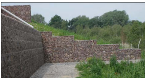
Abbildung 3-5: Fertiggestellte Gabionenwand
