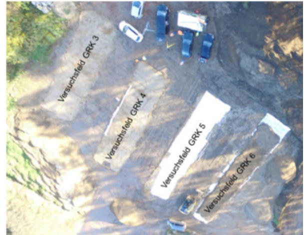
Abbildung 2-3: Vier Testfelder in verschiedenen Stadien des Einbaus von GTX-NW
