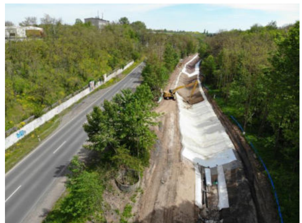
Abbildung 3-1: Luftaufnahme während Bauphase
