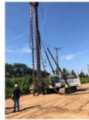
Abbildung 2-6: Herstellung pfahlartige Tragelemente (Betonssäulen unbewehrt)
