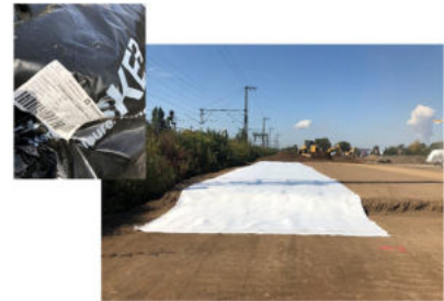
Abbildung 2-7: Verlegung Geokunststoffüberspannung & Betonssäulen
