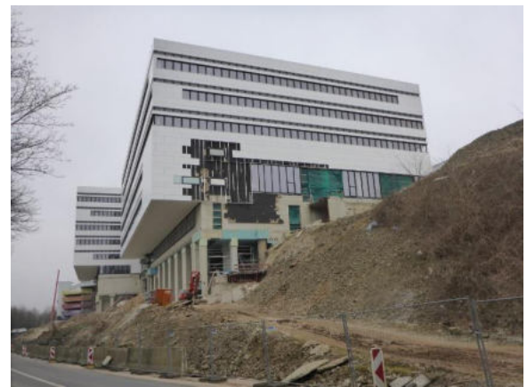
Abbildung 2: Ersatzneubau in Hanglage mit Lastabtrag über Stützen
