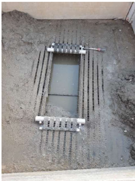
Abbildung 15: Fertig gestellte Öffnung mit Spannvorrichtung in beiden Geogitterlagen.
