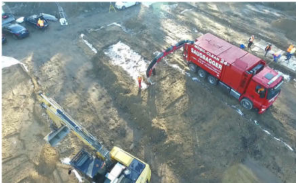
Abbildung 2-5: Abtragen von Schüttmaterial mit einem mobilen Saugbagger
