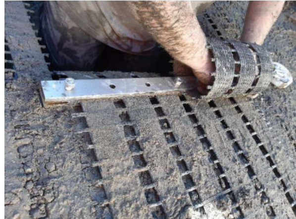
Abbildung 12: Einfädeln der Geogitter in die Klemmvorrichtung.
