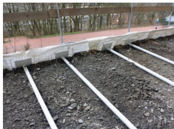
Abbildung 6: Einbau Messstäbe in Hüllrohren
