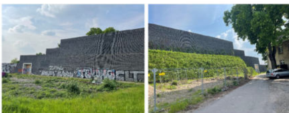
Abbildung 2-15: Wandende West (Bahnseite / Anliegerseite)
