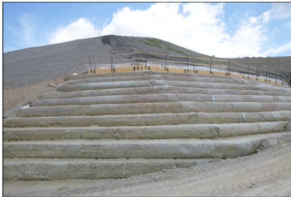
Abbildung 2-4: Fertiggestellte Umschlagmethode mit bereits gezogener Hilfsschalung im unteren Bereich und vorhandener Hilfsschalung im oberen Bereich
