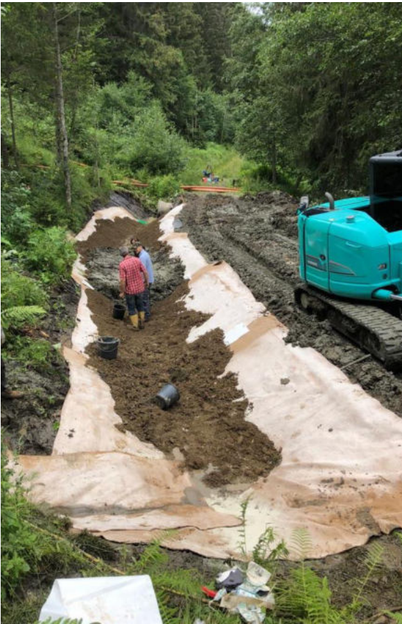
Abbildung 3-2: Einbau einer geosynthetischen Tondichtungsbahn (Bentonitmatte) mit biologisch abbaubaren Träger- und Deckschichten (Vliesstoff- bzw. Gewebekomponenten) als Abdichtung eines Gebirgsbachlaufs in Tirol
