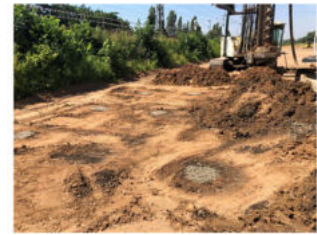
Abbildung 2-6: Herstellung pfahlartige Tragelemente (Betonssäulen unbewehrt)
