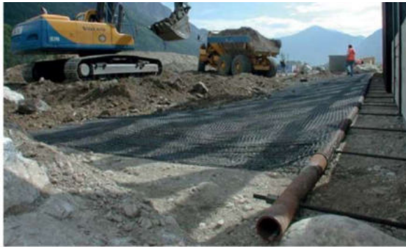
Abbildung 2: Beispielhafte Anwendung des System Schoellkopf zum Anschluss von Geogittern an Verbauwände. [2]
