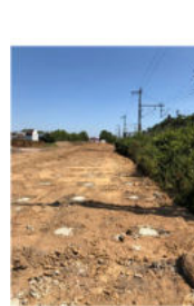
Abbildung 2-7: Verlegung Geokunststoffüberspannung & Betonssäulen
