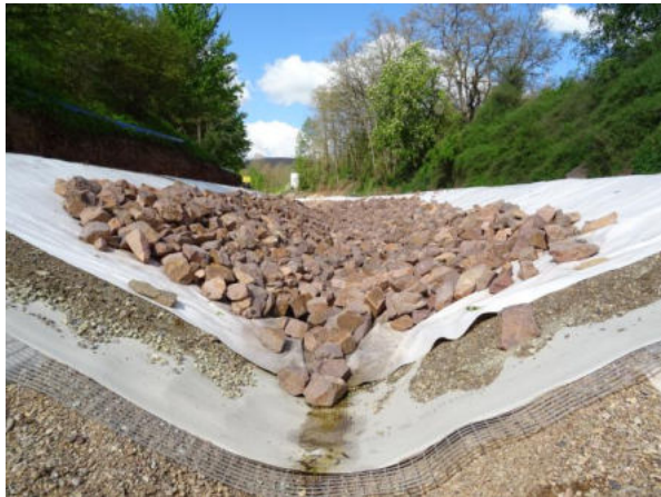
Abbildung 2-2: Grabenprofil mit Geobaustofflagen
