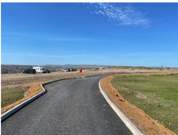
Abbildung 4-2: Fertiggestellte Straße mit biologisch abbaubaren Trenn- und Filtervliesstoffen
