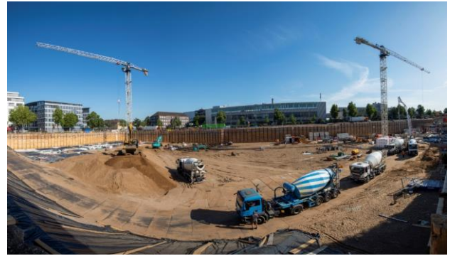
Abbildung 11: Panorama der ausgehobenen Baugrube mit Blickrichtung Nord (Foto: Schüßler-Plan/Dirk Krüll)
