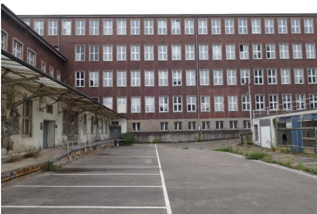
Abbildung 1: Foto des ehemaligen Büro- und Verwaltungsgebäudes an der Heinrich-Ehrhardt-Straße 61 (Foto: ICG)
