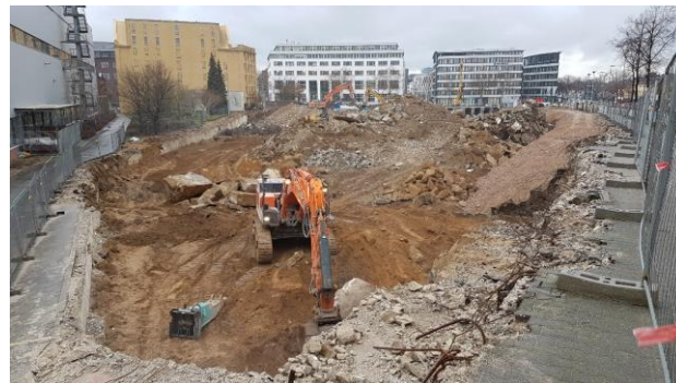
Abbildung 8: Abbruch der Fundamente und Grenzmauern im östlichen Grundstücksbereich (Foto: Reducta)
