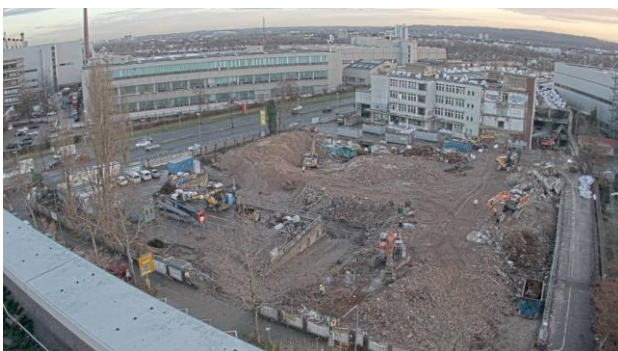
Abbildung 6: Draufsicht auf das Baufeld während des oberirdischen Rückbaus (Foto: Webcam Quantum)
