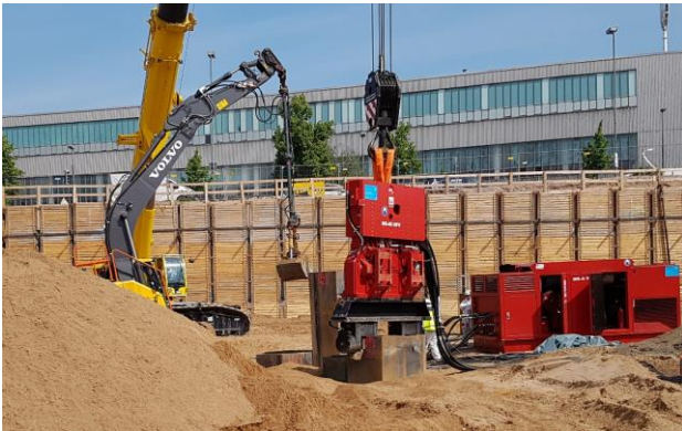
Abbildung 13: Paralleles Einbringen der Waben während des Bodenaustauschs (Foto: ICG)
