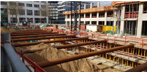
Abbildung 10: Einbau der temporären Innenabsteifung gegen den teilfertiggestellten Neubau (Foto: Schüßler-Plan)
