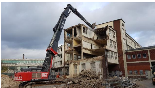
Abbildung 7: Oberirdischer Rückbau Gebäude A (Foto: Reducta)
