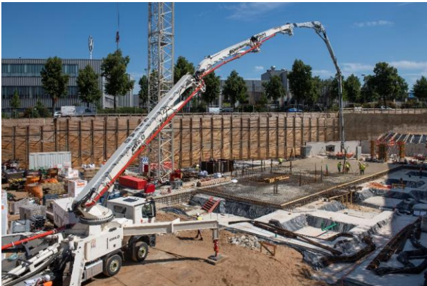
Abbildung 18: Baustellenfoto Rohbaustart (Foto: Schüßler-Plan)
