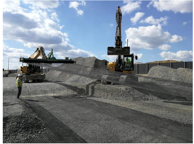
Abbildung 5 - Hängende Verlegung des unteren Geogitters unter gleichzeitiger Vorspannung: eine Besonderheit
