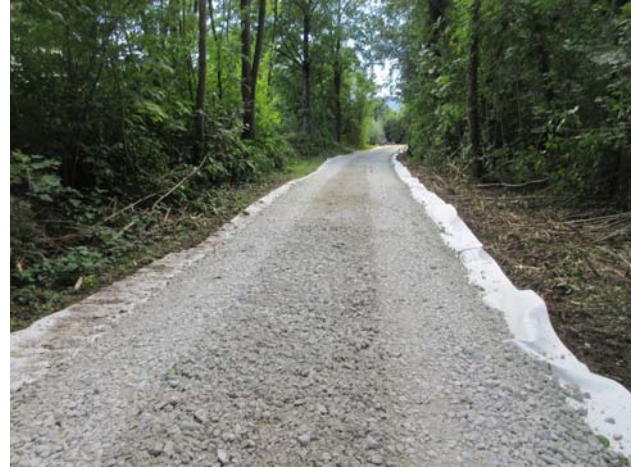
Abbildung 4-1: Mit biologisch abbaubarem Vliesstoff hergestellte Baustraße bei Dettingen
