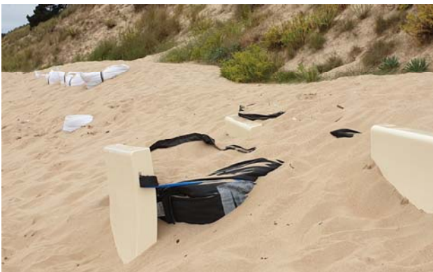
Abbildung 2-4: Verwendung ungeeigneter Verpackungsprodukte und Kunststoffe für Küstenschutzmaßnahmen, Frankreich 2019
