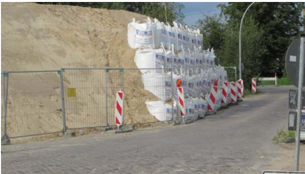
Abbildung 2-3: Zweckentfremdung von Verpackungsprodukten für geotechnische Nutzungen bei unklaren Bemessungsrandbedingungen, Hamburg, 2011
