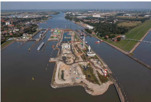
Abbildung 1: Baustelle der 5. Schleusenkammer (Jahr 2021)
