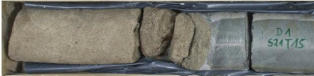
Abbildung 6: Scharfer Übergang zwischen Düsenstrahlsäule und Boden
