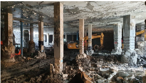
Abbildung 3-3: Aushub unter Deckel 02
