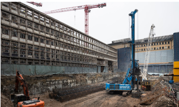
Abbildung 5-2: Herstellung von Gründungspfählen vor der denkmalgeschützten Fassade
