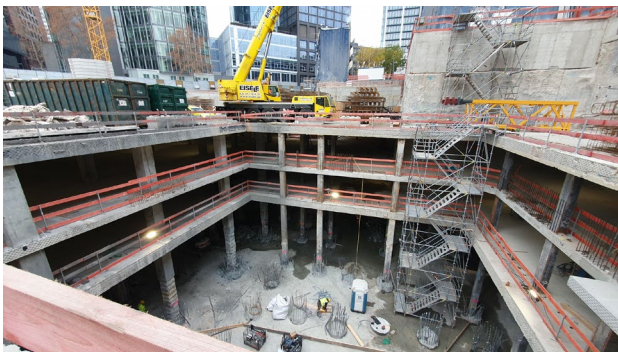
Abbildung 6-4: Freilegend der Pfählköpfe im Bereich Tower 4
