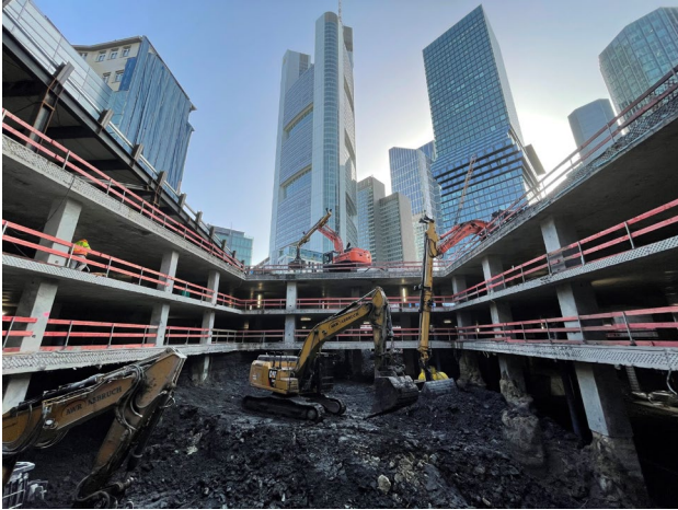
Abbildung 3-2: Aushub unter Deckel 02
