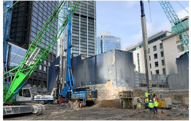
Abbildung 5-3: Einbau einer Primärstütze
