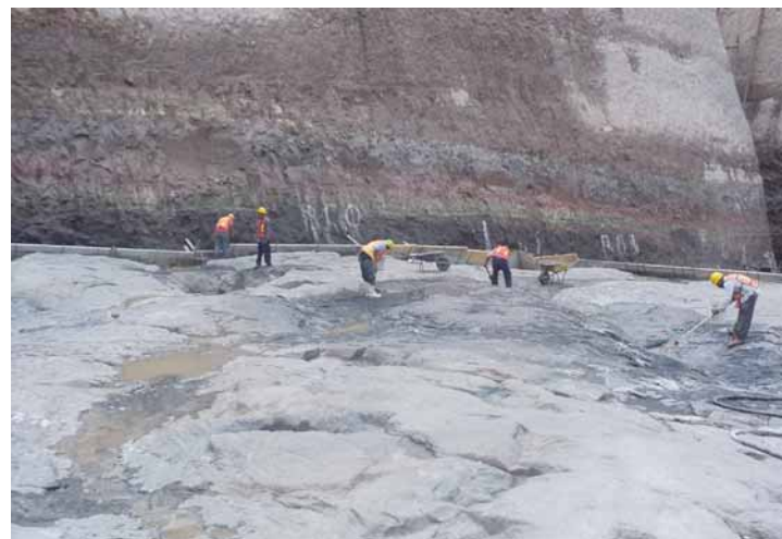
Bild 6. Dolerit in der Gründungssohle.
