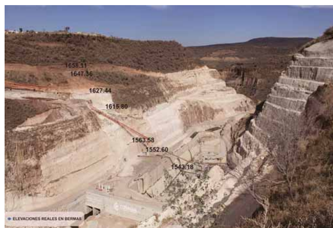
Bild 2. Die Baustelle im Januar 2012.
