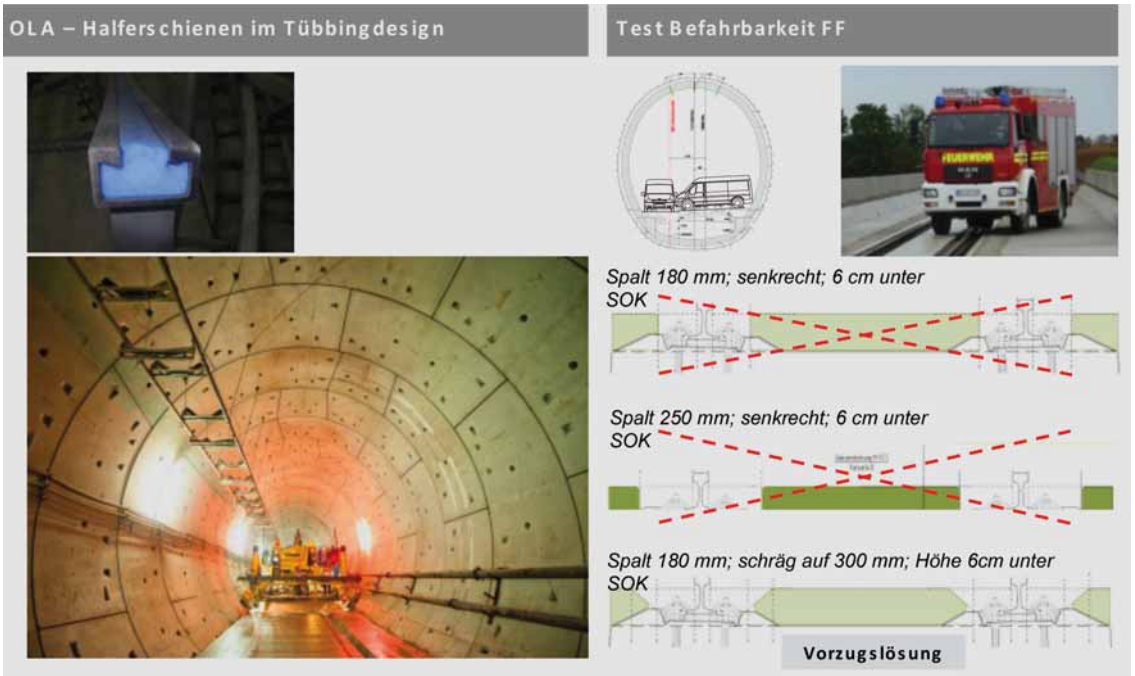
Bild 5. Oberleitung und Feste Fahrbahn.
