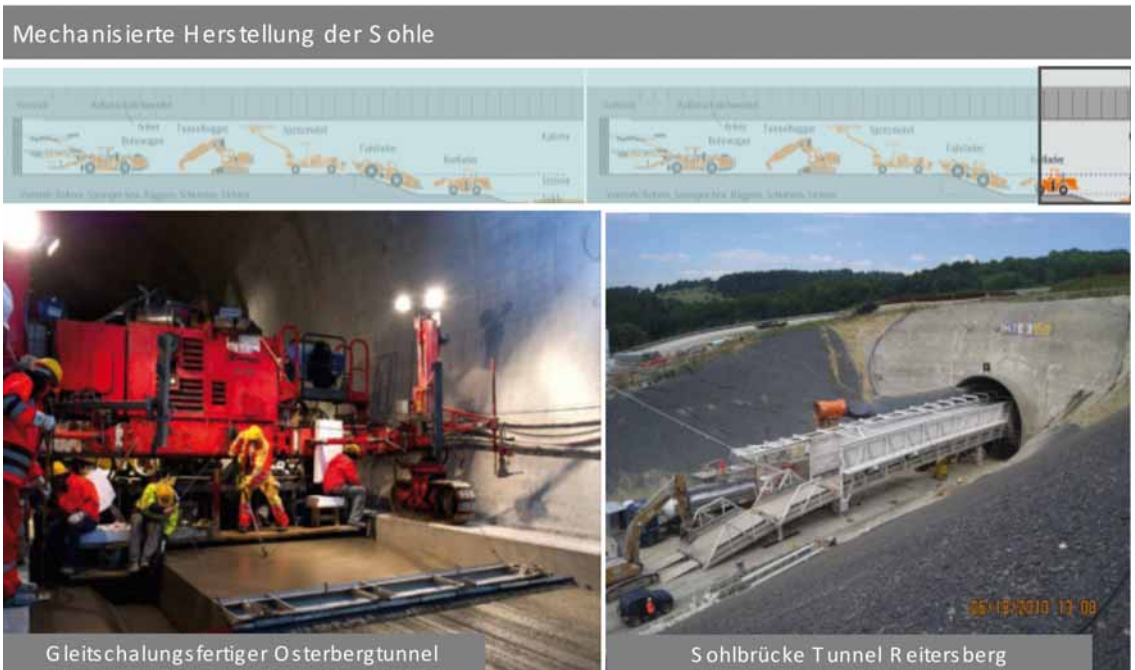
Bild 4. Tunnel in NÖT-Bauweise.
