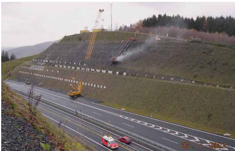
Bild 6. Sicherungsarbeiten am Nordhang.
