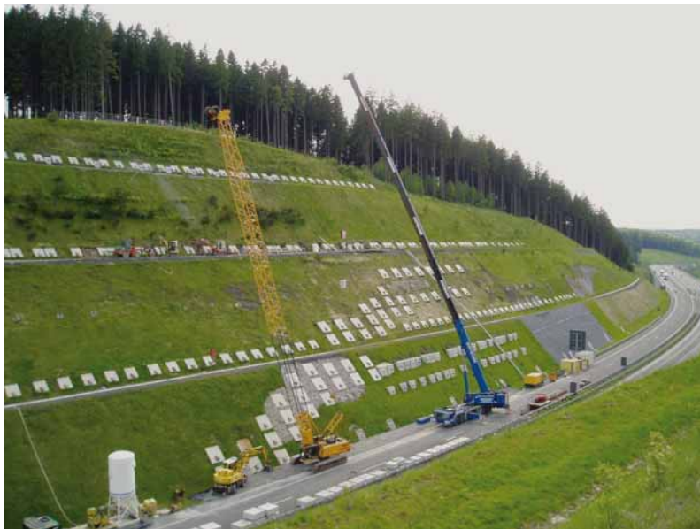
Bild 5. Sicherungsarbeiten am Südhang.
