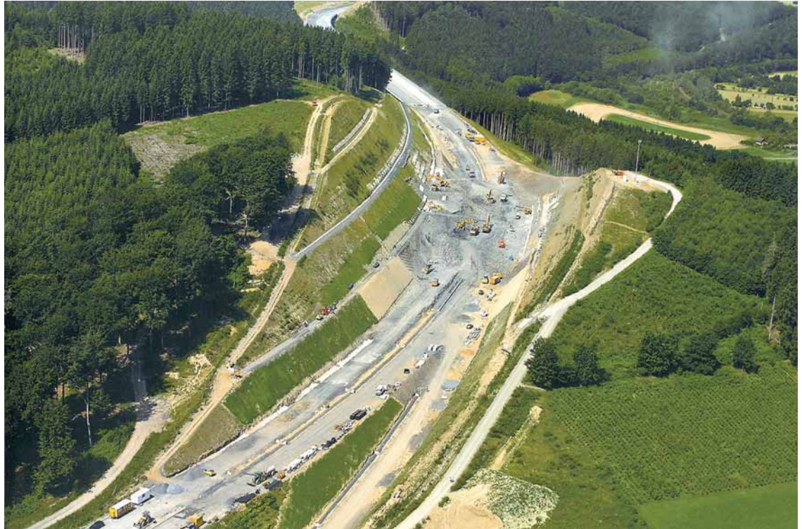
Bild 1. Luftaufnahme des Einschnitts.
