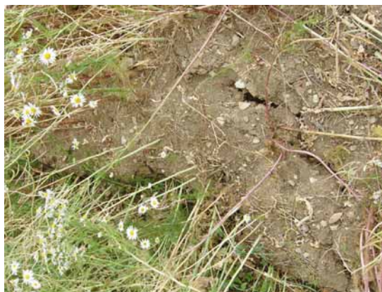
Bild 5. Wulstbildung und Überschiebung im Vorland der Böschung.
