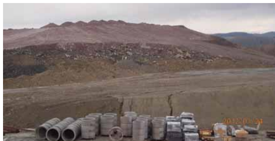
Bild 8. Deponie über Tunnelkreuzung.
