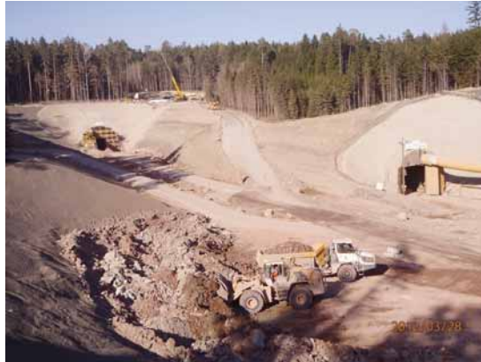
Bild 2. Links Höhenbergtunnel, rechts Füllbachtunnel.
