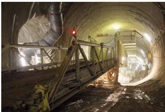
Bild 12. Verlegung der Versorgungsleitungen Hauptvortrieb über Notausgang 1.
