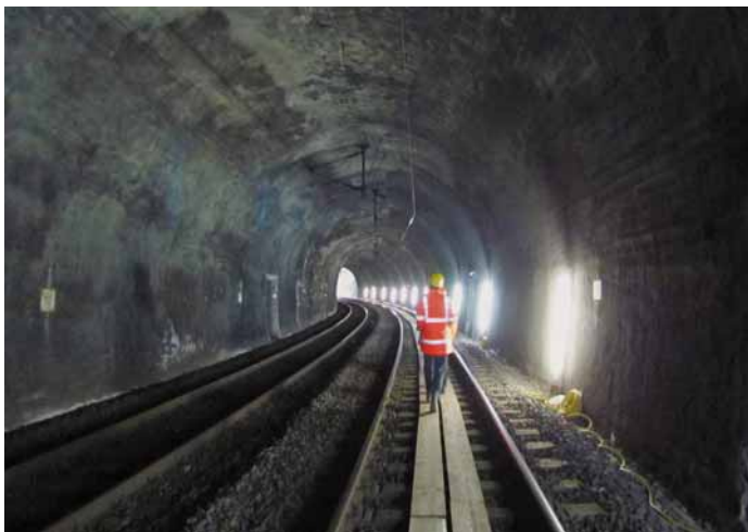
Bild 8. Visuelle Kontrolle des Bestandstunnels.
