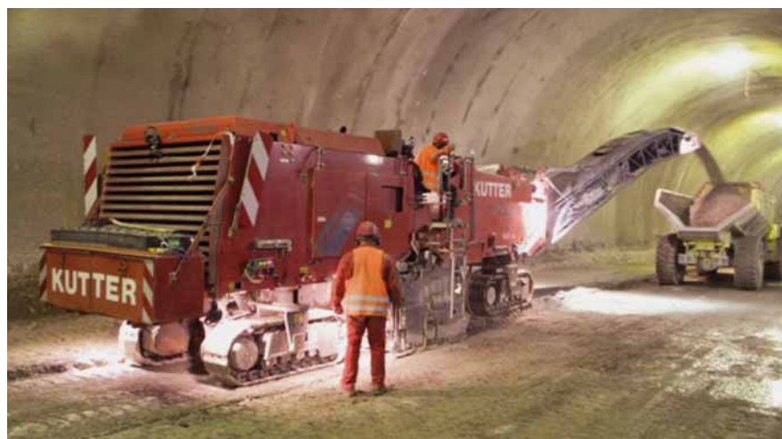
Bild 11. Fräsvorgang zum Auffahren der Sohle.
