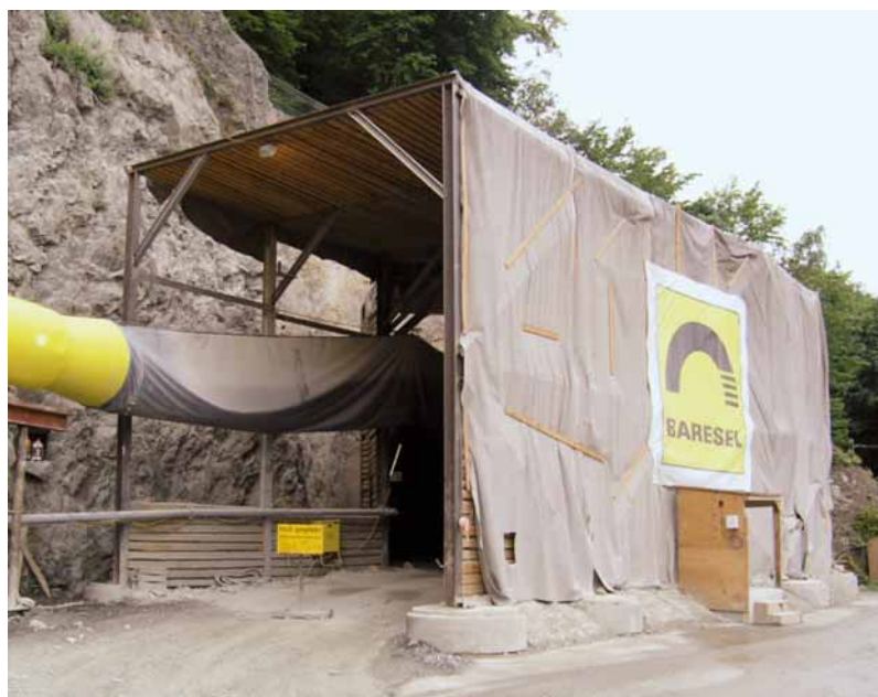
Bild 2. Schutzeinhausung gegen Streuflug.
