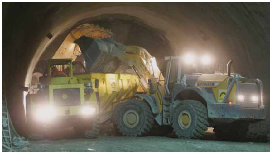
Bild 9. Schüttern des Tunnelausbruchs.
