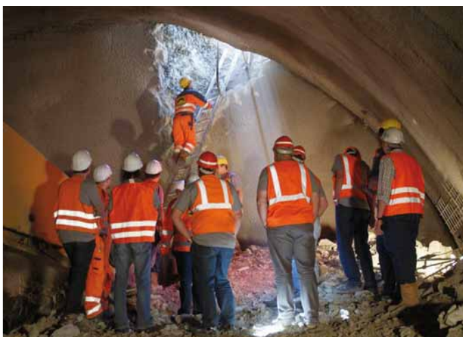
Bild 10. Durchschlag des neuen Eppsteiner Tunnels.
