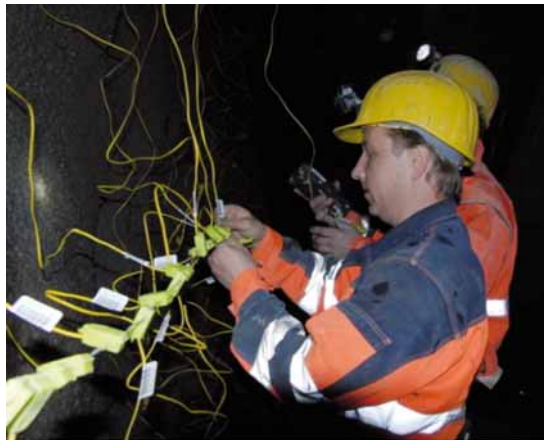
Bild 3. Verdrahten und Scannen der elektronischen Zünder.
