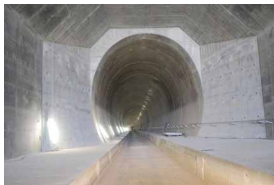
Bild 12. Bibratunnel – Tunnelröhre mit Innenschale.
