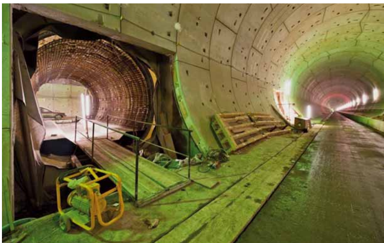
Bild 8. Tunnelröhre im Rohbau mit Querschlag.
