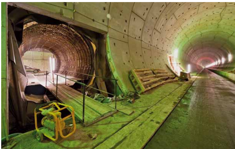
Bild 8. Tunnelröhre im Rohbau mit Querschlag.
