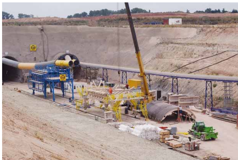
Bild 15. Voreinschnitt Ost und Förderband für die Schutterung.
