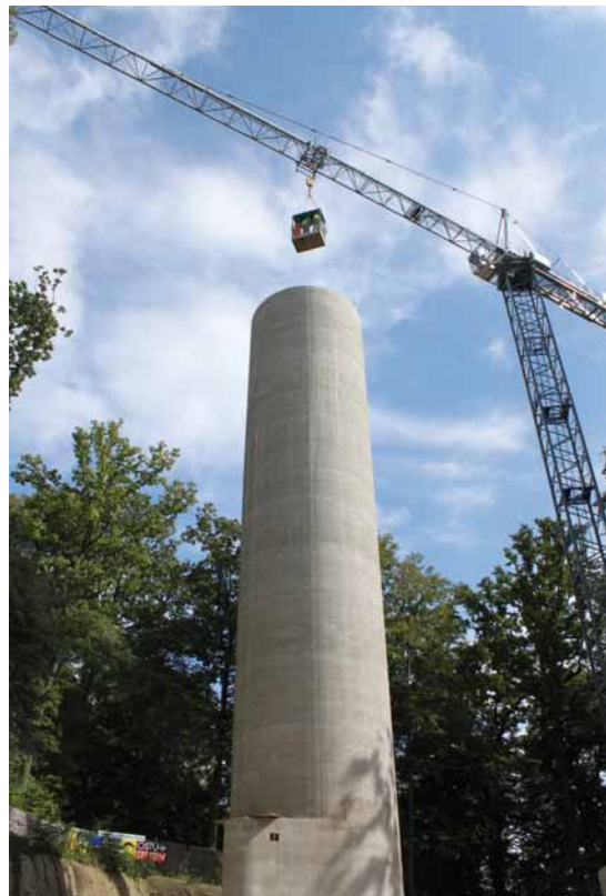
Bild 19. Abluftkamin in der Bauphase – der fertiggestellte Kamin ist 157 m hoch.
