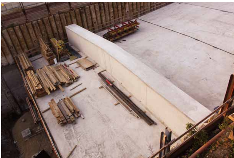
Bild 5. Erster, einzellig spannender Block mit Überzug.
