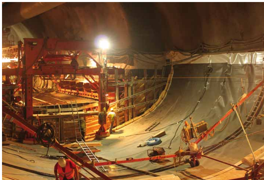
Bild 8. Abdichtung und Betonage der Sohle.
