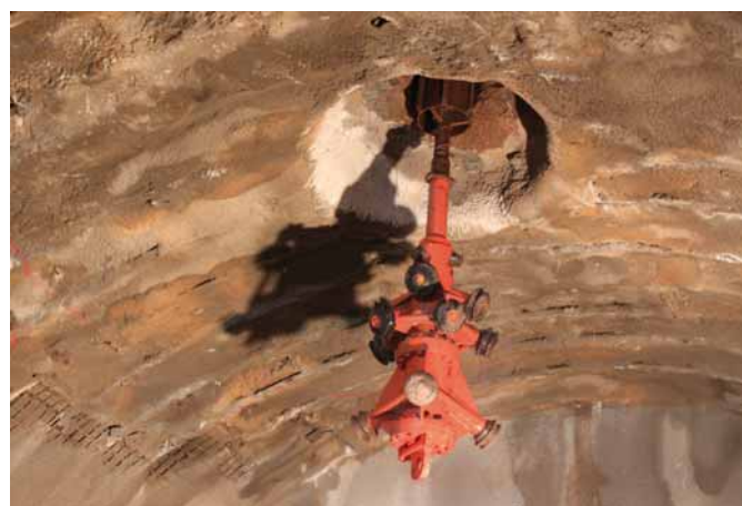
Bild 15. Reamer vor dem Aufwärtsschnitt.
