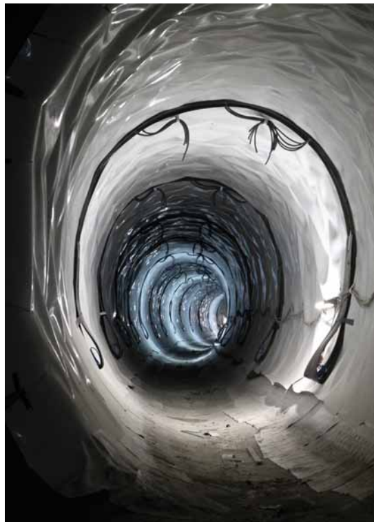
Bild 11. Hochgeklappte Abdichtung im Sohlbereich des Rettungstollens.
