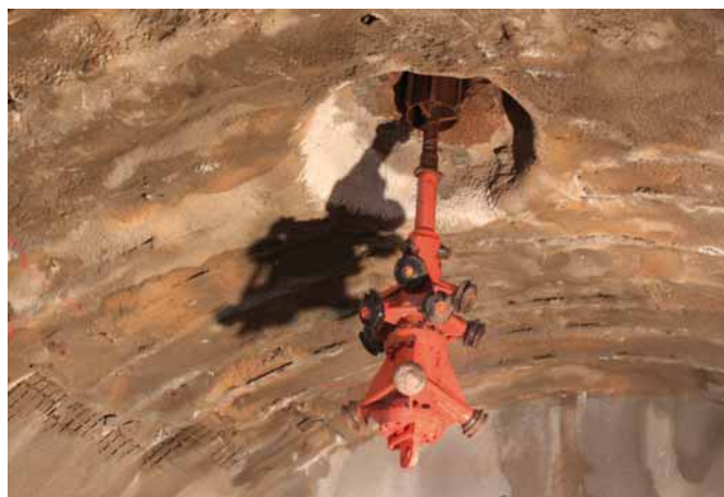
Bild 15. Reamer vor dem Aufwärtsschnitt.
