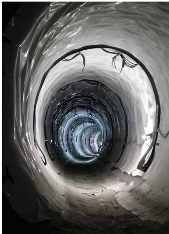
Bild 11. Hochgeklappte Abdichtung im Sohlbereich des Rettungstollens.
