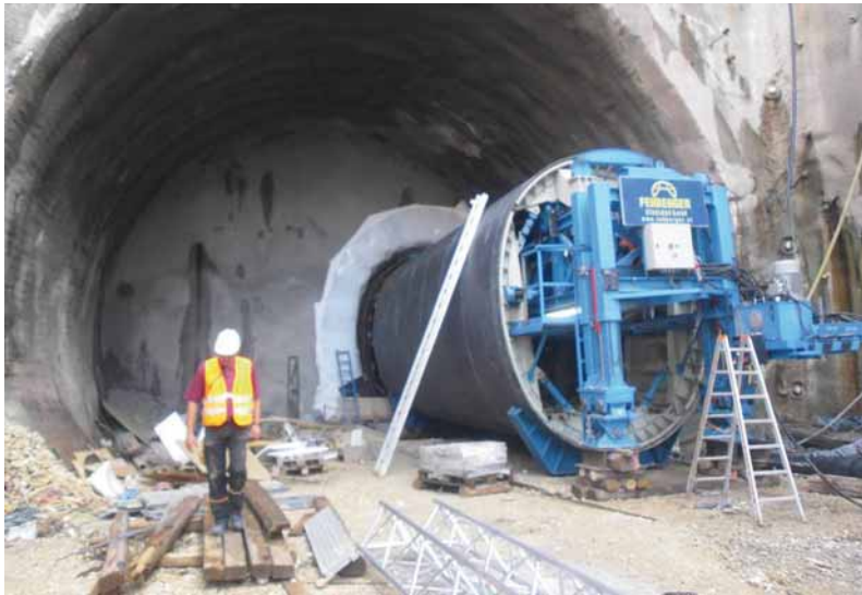
Bild 9. Fullround-Schalwagen, nicht eingefahren.
