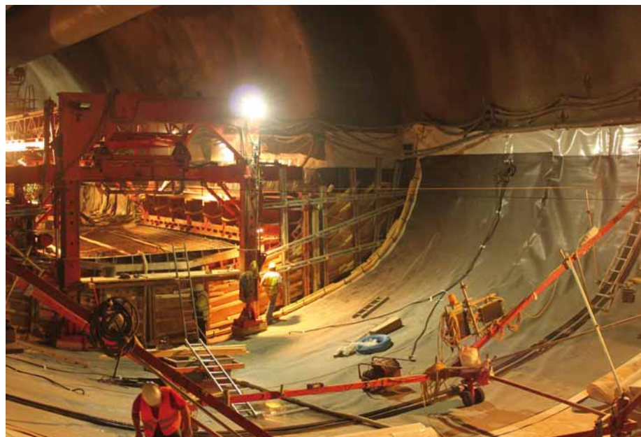
Bild 8. Abdichtung und Betonage der Sohle.
