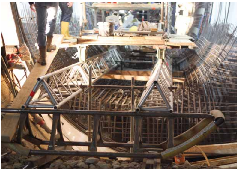
Bild 12. Bewehrungsschlitten im Rettungstunnel.
