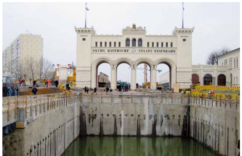
Bild 1. Portikus mit Baugrubenverbau Bayerischer Bahnhof.
