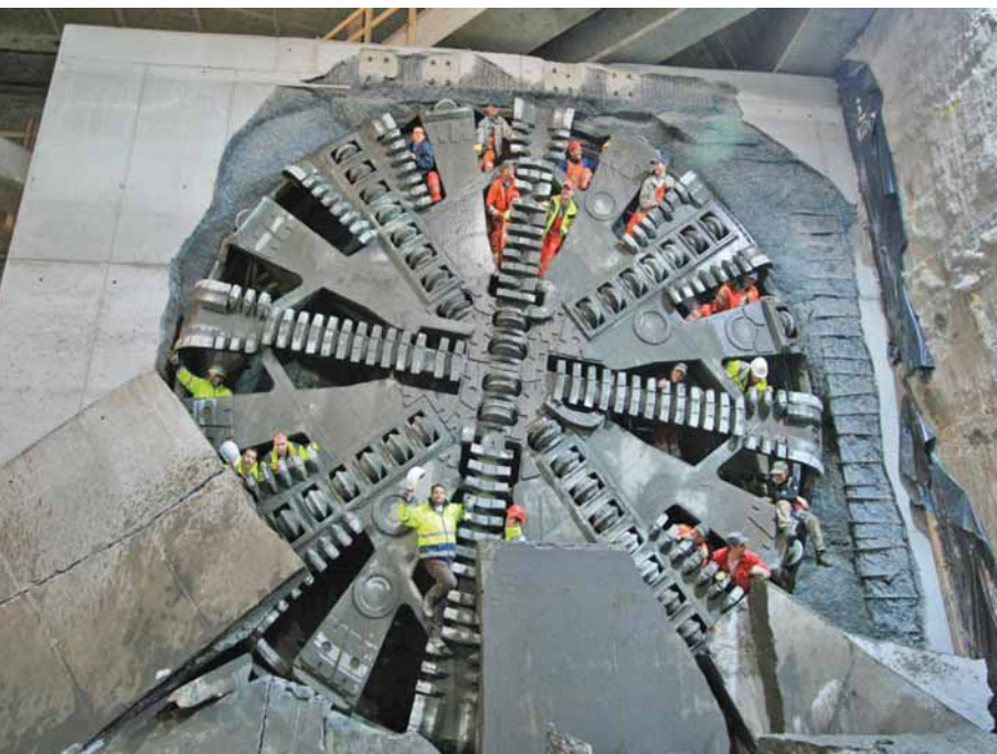
Bild 2. Ausfahrt in die Station Hauptbahnhof am 31.10.2008.
