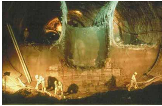
Bild 3. B 14, Heselcher Tunnel, 3-spuriger Querschnitt am Marienplatz.
