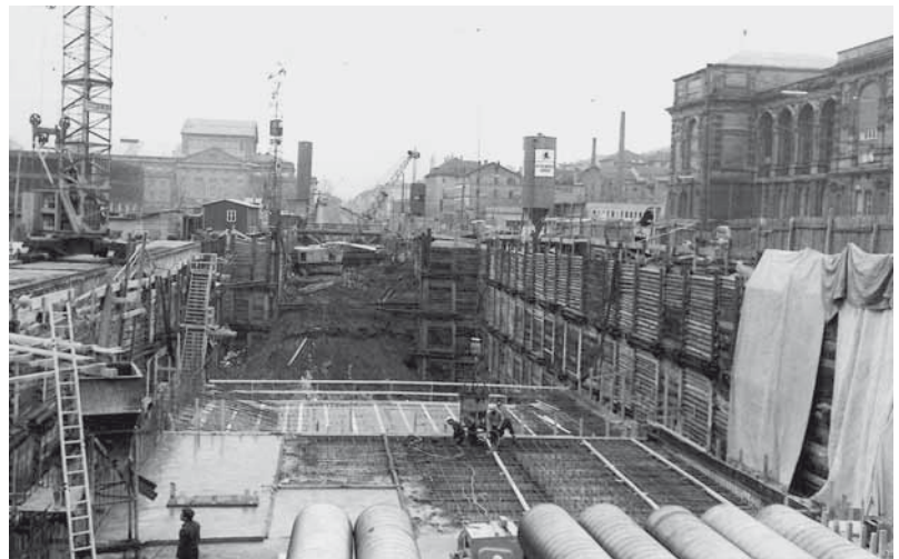
Bild 1. Baugrube am Charlottenplatz in den 1960er-Jahren.
