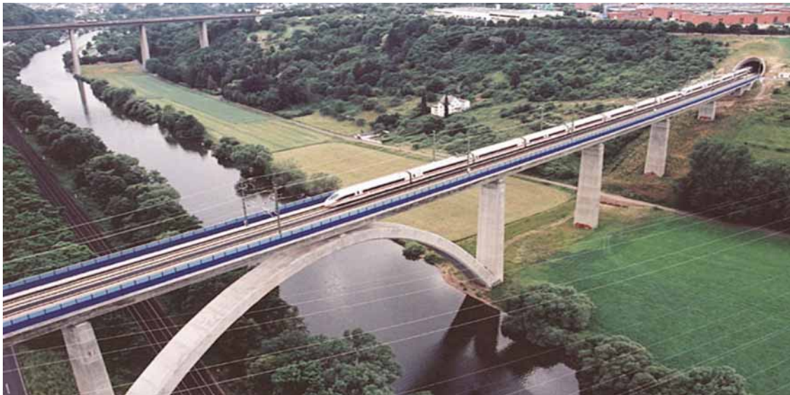
Bild 2. Sicheres Betreiben des Fahrwegs der Bahn: Lahntalbrücke Köln-Rhein/Main.
