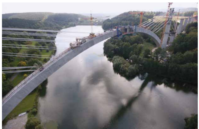
Bild 3. Sicheres und wirtschaftliches Planen und Bauen des Fahrwegs der Bahn: Talbrücke Froeschgrundsee VDE 8.2.
