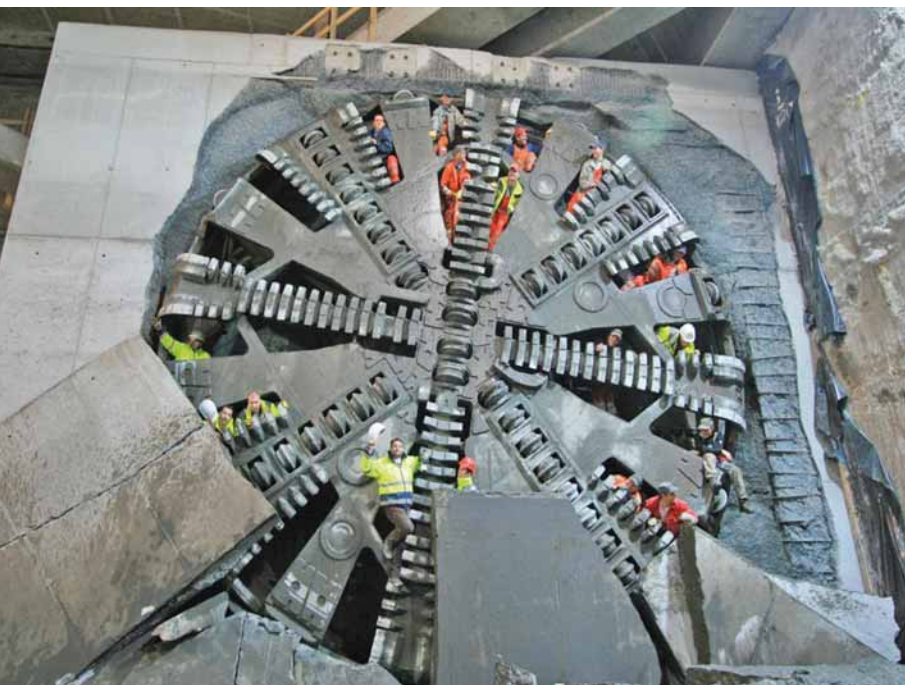
Bild 2. Ausfahrt in die Station Hauptbahnhof am 31.10.2008.
