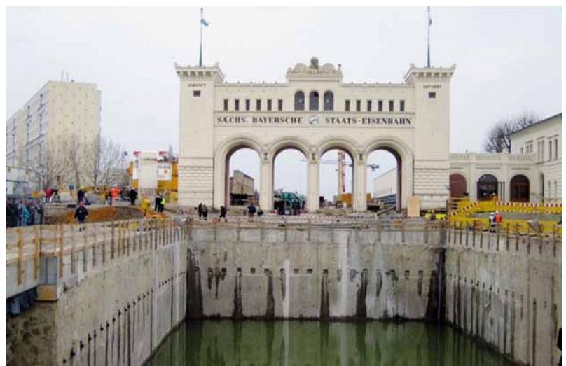
Bild 1. Portikus mit Baugrubenverbau Bayerischer Bahnhof.
